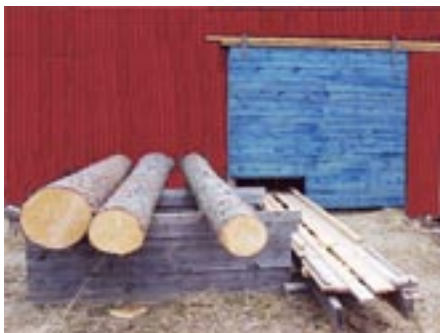
Skjutporten på baksidan har urtag nertill för att ge plats åt stockbanan.
